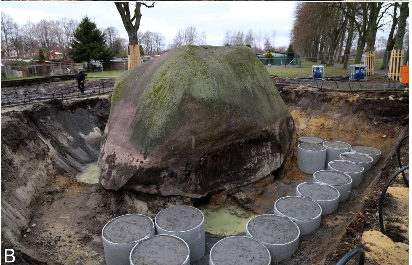
Abb. 2: A Der Granitfindling wird mit Baggern bis zu seiner Basis freigelegt. B Betonfundamente dienen als Unterlager für die Stahlkonstruktion. (Fotos: K. Obst, 2021)
