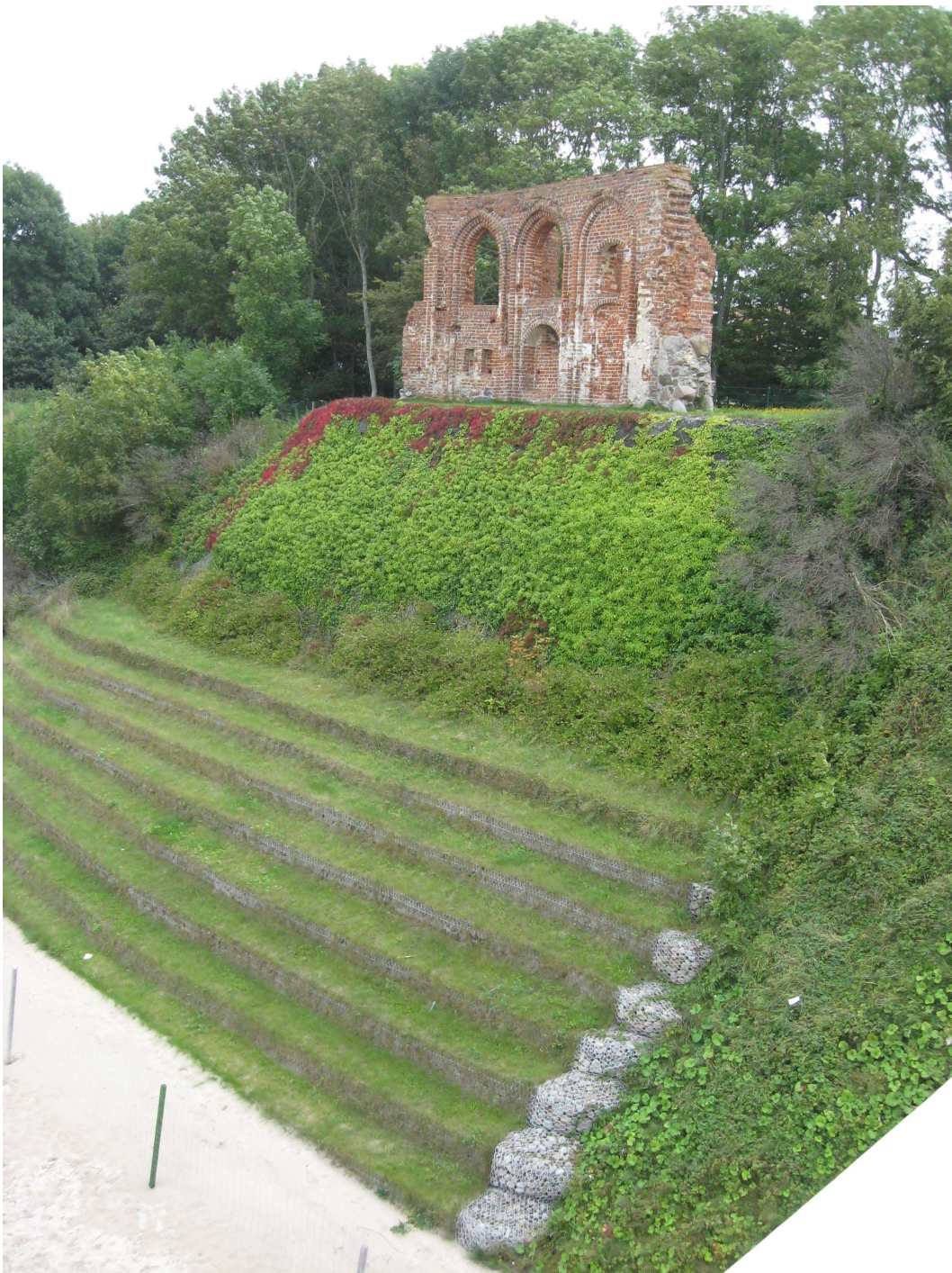
Abb. 4: Die Kirchenruine in Trzesacz. Im Vordergrund sind die getroffenen Küstenschutzmaßnahmen zu sehen, bei denen mit Steinen gefüllte Drahtkörbe im Steilufer eingebaut wurden.
