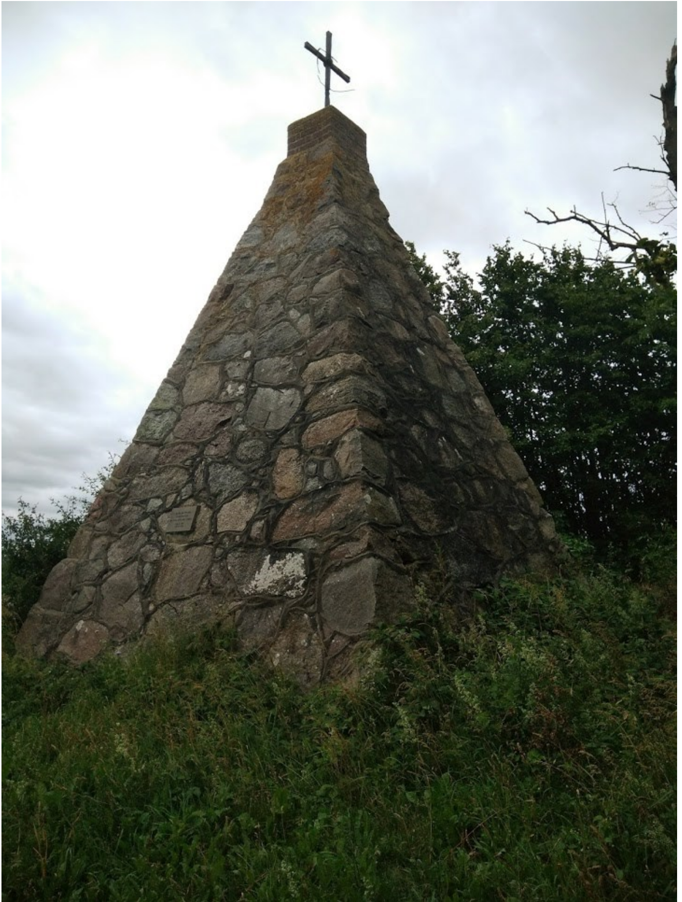
Abb. 1: Aus kristallinen Geschieben errichtete Grabpyramide auf dem Tempelberg bei Penzlin, geschätzte Höhe ca. 5,5 m. Foto: S. Hennig.
