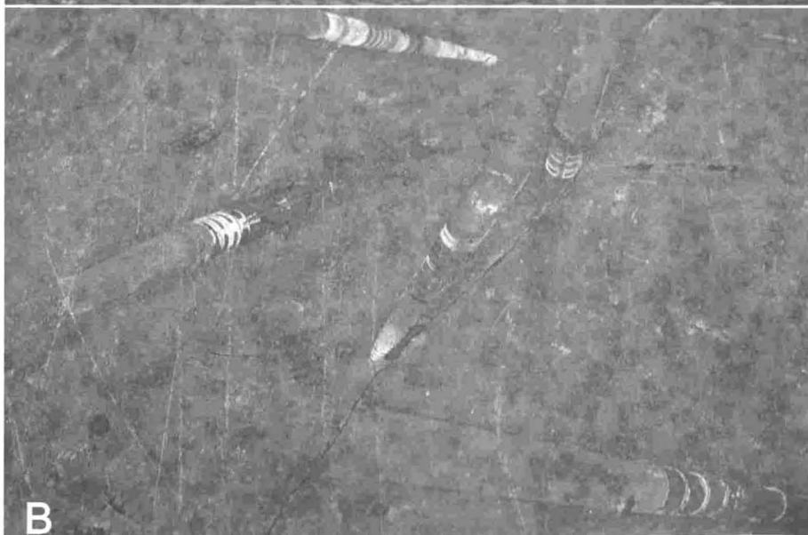
Tafel 3 A Greifswalder Dom St. Nikolai, Gotländer Korallenkalk als Verblendsteine am Westportal. B Greifswalder Dom St. Nikolai, ehemalige Grabplatte aus Rotem Orthocerenkalk als Trittstufe am westlichen Portal des nördlichen Seitenschiffes, Bildbreite 40 cm.
